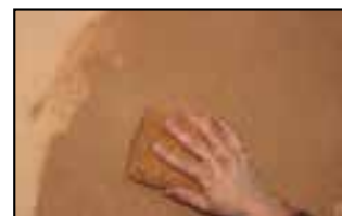
Étape 4 - une fois l'enduit sec, passage d'une éponge semi-humide afin de faire tomber les poussières de surface et faire ressortir la fibre de paille.
